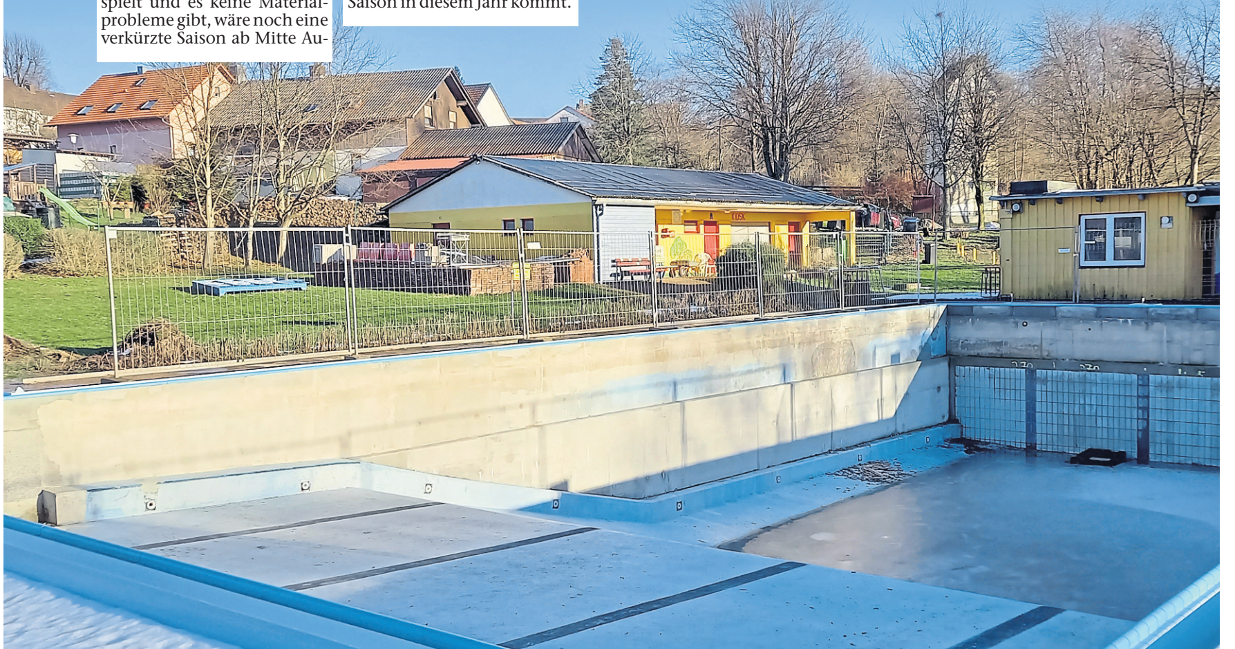
Die Sanierung musste im vergangenen Jahr abgebrochen werden. Jetzt hoffen die Verantwortlichen, dass die Arbeiten bis Spätsommer abgeschlossen werden können. Foto: Ingo Sommers
